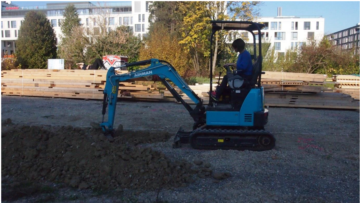
Amanda Felber 2017 beim Baggern der Streifenfundamente. Im Hintergrund lagert das Holz des Pavillons
