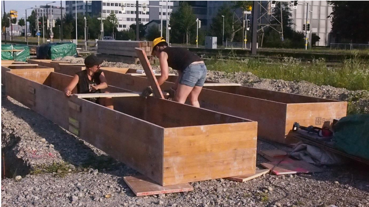
Vorstandsfrau Eva Ramseier schreinert zusammen mit Baumeisterin Franziska die Schalungen für die Streifenfundamente des Pavillons
