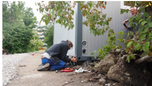
Sanitär Christoph schliesst den Container an Wasser und Kanalisation
